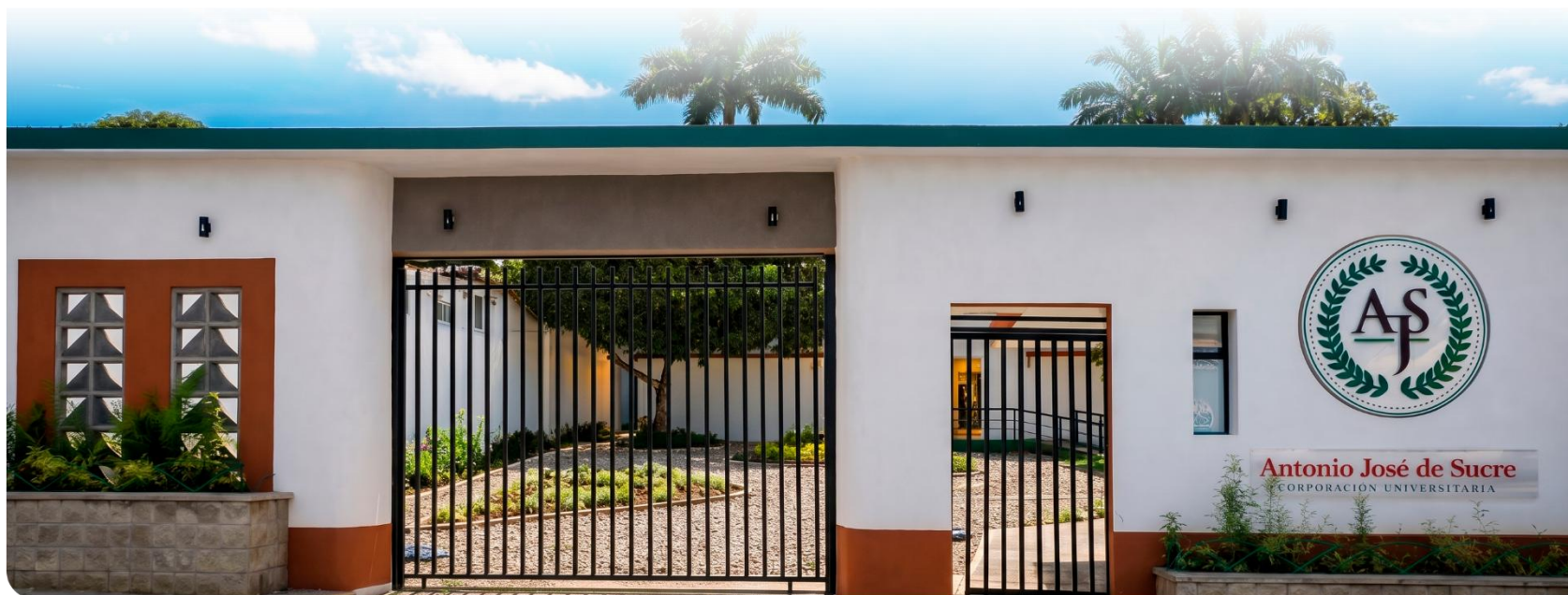
FOTOGRAFÍA 3. INSTALACIÓN C, AVENIDA EL ZUMBADO
